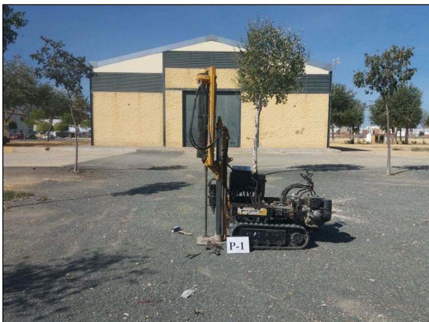
En el Anejo nº 4 se adjuntan las diagráfias profundidad/N<sub>20</sub> obtenidos de los ensayos penetrométricos realizados. Estos diagramas reflejan una medida indirecta, y casi continua, de la resistencia y de la deformabilidad de los distintos estratos atravesados.
